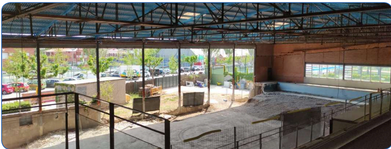
Inici dels treballs d'enderroc de les piscines 1 i 2.
